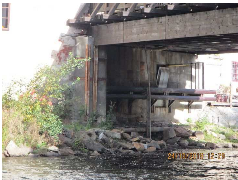
Obr.č.6: Opěra P3 - chybí část kamenné rovnaniny u paty podpěry.
