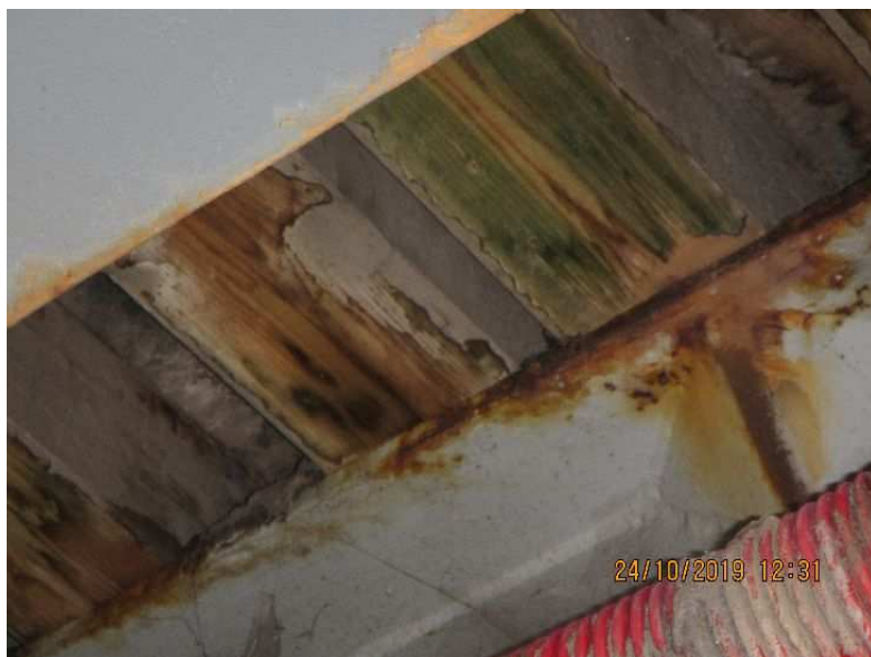
Obr.č.7: Příčnický – hniloba postupuje k povrchu. Lokální koroze horní pásnice nosníku.
