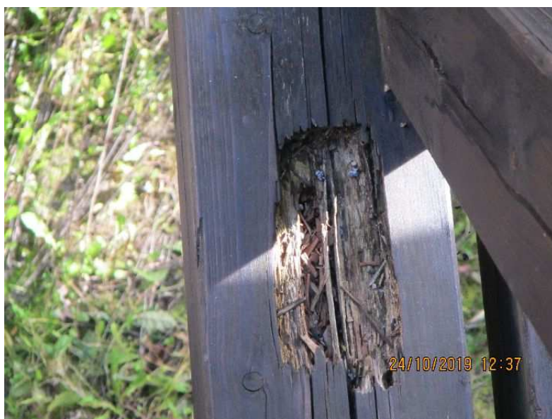
Obr.č.12: Hnědá hniloba příčníků prorazila na povrch.
