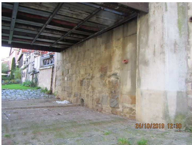
Obr.č.5: Opěra P1- mapy od stékající vody z úložného prahu.
