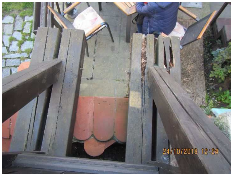
Obr.č.11: P1- hnědá hniloba příčníků prorazila na povrch.
