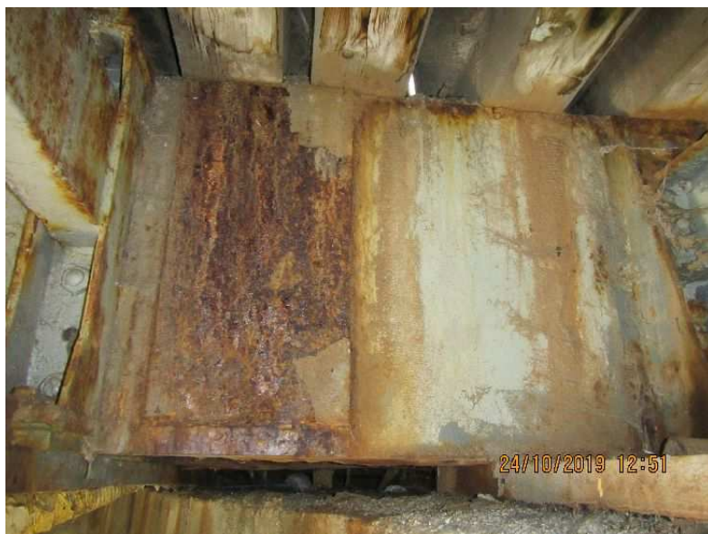
Obr.č.10: P3 – koroze stěny nosníku.
