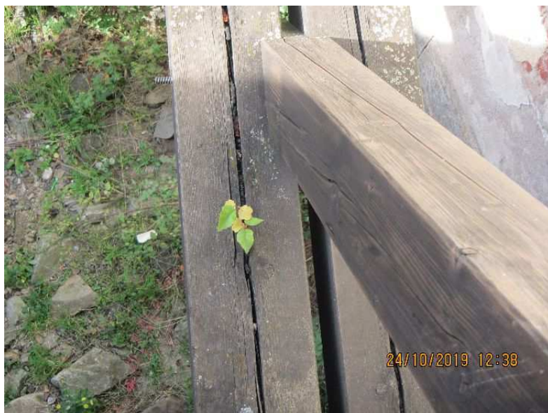
Obr.č.13: Plodnice Trámovky plotní a vegetace v trhlině příčnicku.
