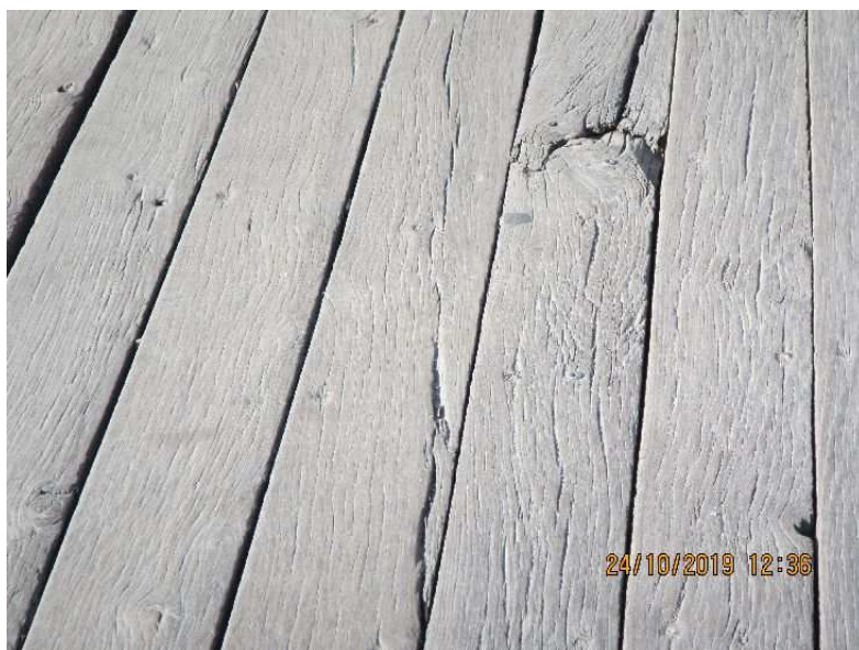
Obr.č.14: Rozlámané dubové fošny vozovky.
