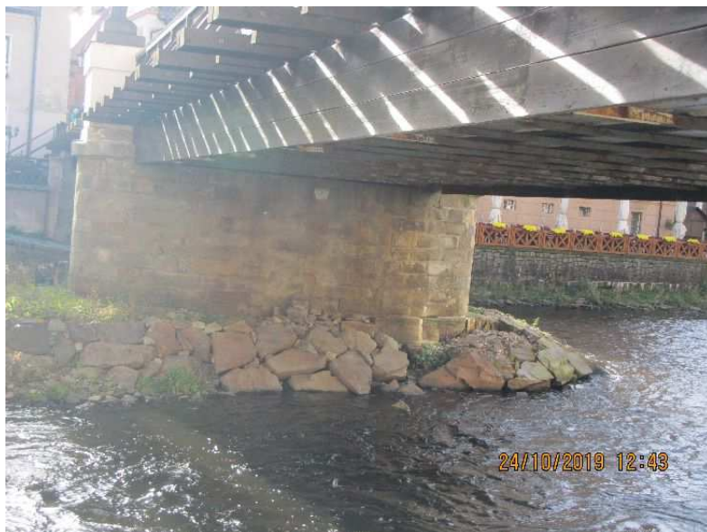
Obr.č.4: P2 – chybí část kamenné rovnaniny u paty podpěry.
