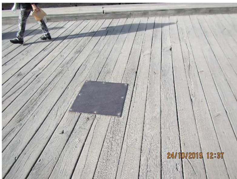
Obr.č.15: Vyspravovaná vozovka plechem.
