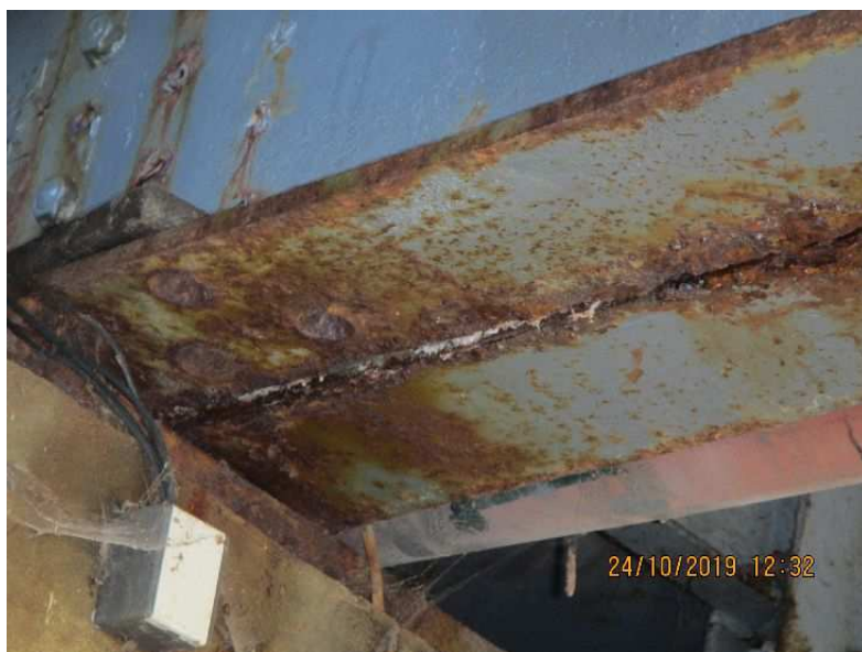
Obr.č.8: P1 – Koroze dolní pásnice nosníků.
