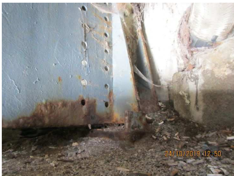
Obr.č.9: P3-nečistoty na úložném prahu. Koroze ložisek.
